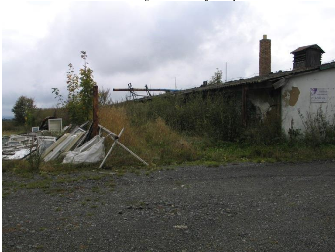
Foto 9: Pohled na chátrající budovy na ploše P1.
