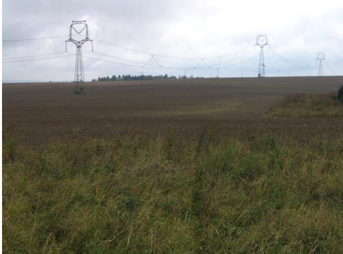
Foto 15: Pohled na trasu stávajícího vedení VVN.
