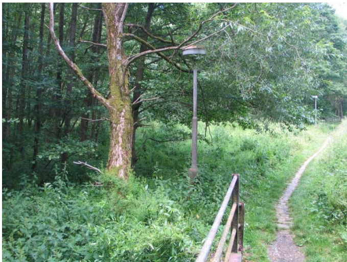
Foto 11: Pohled na stávající chodník v místě plochy Z24 – pohled ze stávajícího mostu přes boční rameno Moravice.
